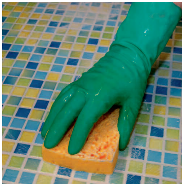
Etter fuging vaskes flaten med en svamp.
