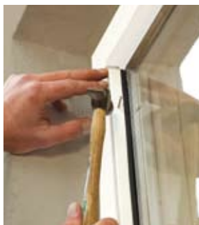
Glasslister monteres med rustfri buet spiker A2-A4.
