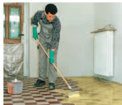
PCI Gisogrund 303 er en sikker heftgrunn for keramiske fliser på glatte/ikke sugende underlag.
