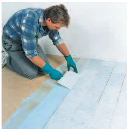
Med reaksjonsharpiksfliselimet PCI Collastic kan det også legges marmor på tresponplater.
