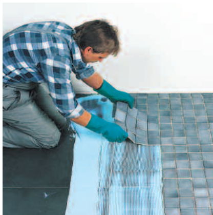
Fliser eller plater settes på og innrettes i påførtelimlag.
