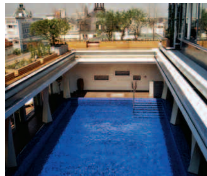
Fliser lagt med PCI Collastic i et Svømmebasseng.
