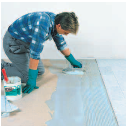
PCI Collastic egner seg som fliselim på fuktighetsfølsomme underlag, slik som f.eks. tresponplater.
