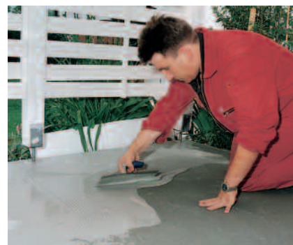
PCI Seccoral 1K-tetningen kan pensles eller sparkles på vegger eller gulv.
