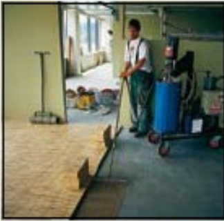
Limten påføres undergulvet
