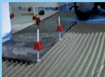
Figur 8: System med strammestrips og firkantete klosser
