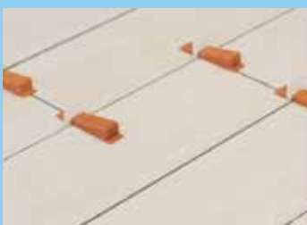
Figur 9: System med bøyer og kile
