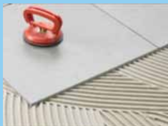
Figur 4: Bruk av vakumløfter letter arbeidet for flisleggeren
