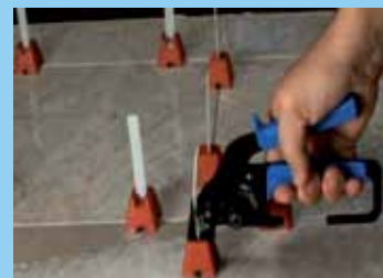
Figur 8: System med strammestrips og firkantete klosser
