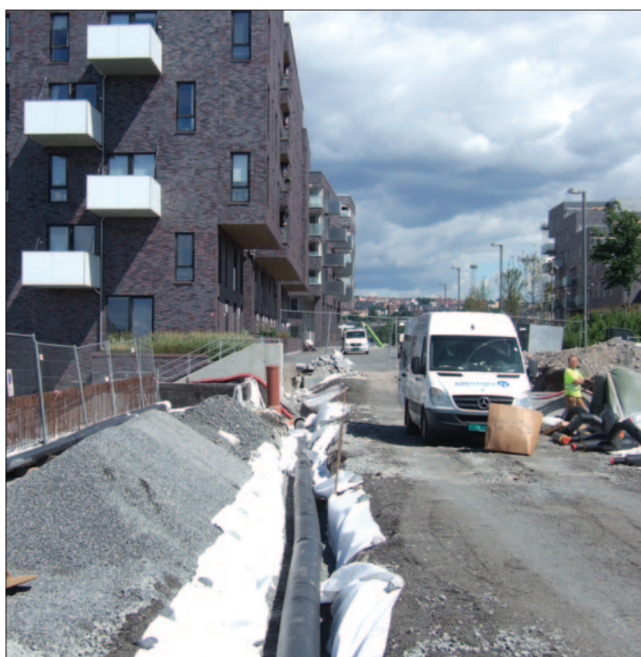
Isovarm som både vann- og avløpsledninger for større boligprosjekt på Sørenga i Oslo
