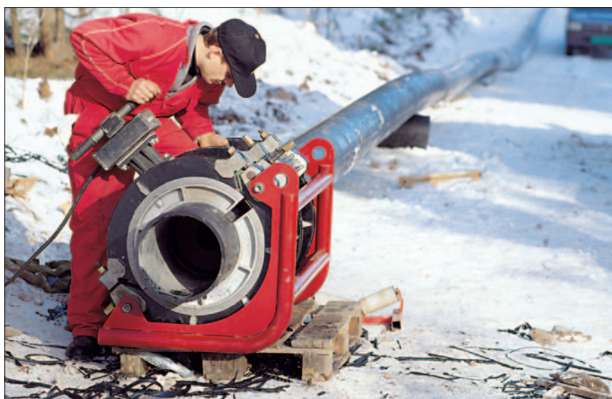
Speilsveising av PE trykkør
