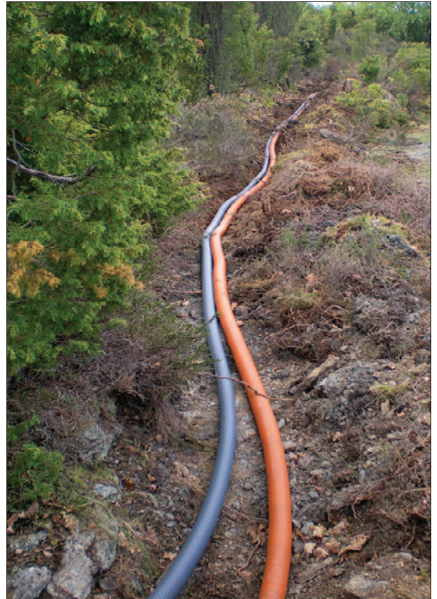
Eksempel på Isoterm vann og trykkavløp i grunne grøfter
