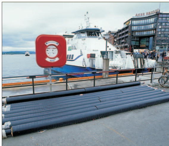
Isovarmledninger under Aker brygge
