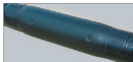
Ferdig etterisolert sveiseskjøt
