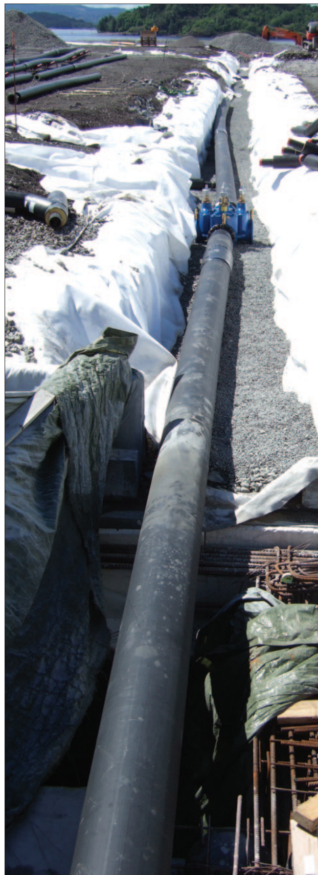
Isovarm som både vann- og avløpsledninger for større boligprosjekt på Sørenga i Oslo
