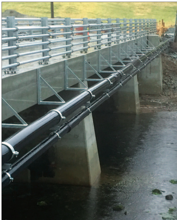
Overføringsledning med vann og avløp, Tømmernes bro, Os kommune
