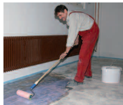
PCI Gisogrund Rapid påføres ufortynnet med en skumgummirulle jevnt over hele flaten. Allerede etter 15 minutter kan det arbeides videre med PCI fliselim eller PCI sparkelmasser.
