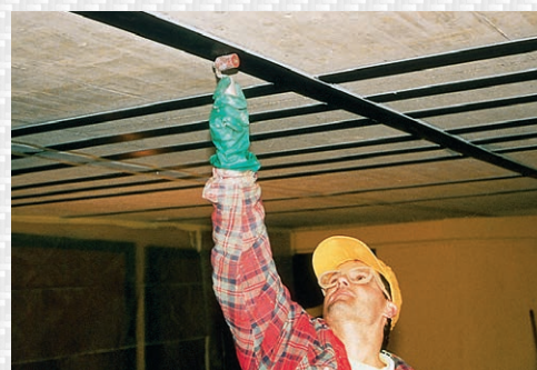
Forsterkning av armert betongdekke med SIKA CARBODUR SYSTEMET: Sikadur 30 epoksyrim og Sika CarboDur –bånd.
