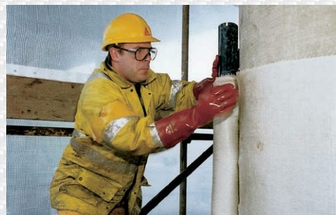
Påføring av SikaWrap for forsterkning av en brusøyle mot påkjørsler.
