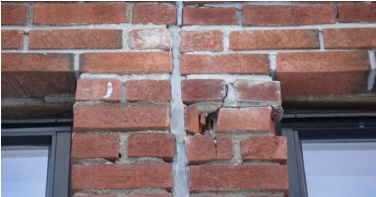
En uheldig sammenføring av prefabrikkert bjelke og det gamle murverket.
