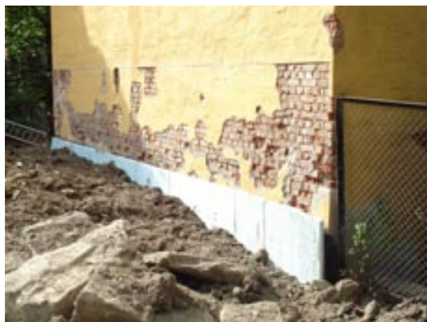
Muren ferdig fuktsikret og isolert utvendig. Isolasjonsleverandøren kan gi råd om knotteplast bør plasseres utenfor isolasjon eller mellom isolasjon og vegg.
