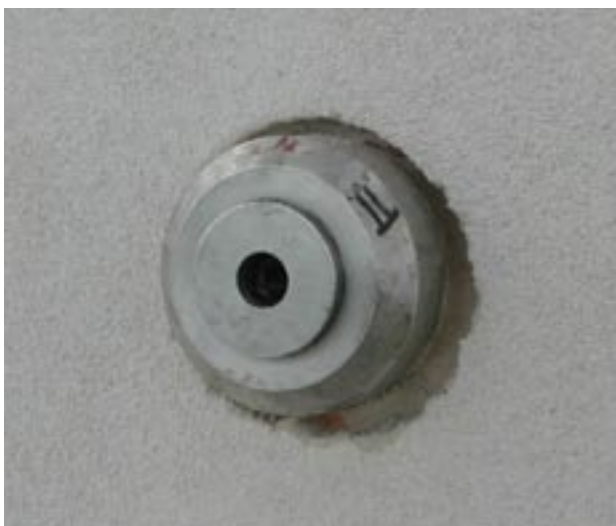
Festebrakett for avtrekksapparat pålimes det isolerte underlaget.
