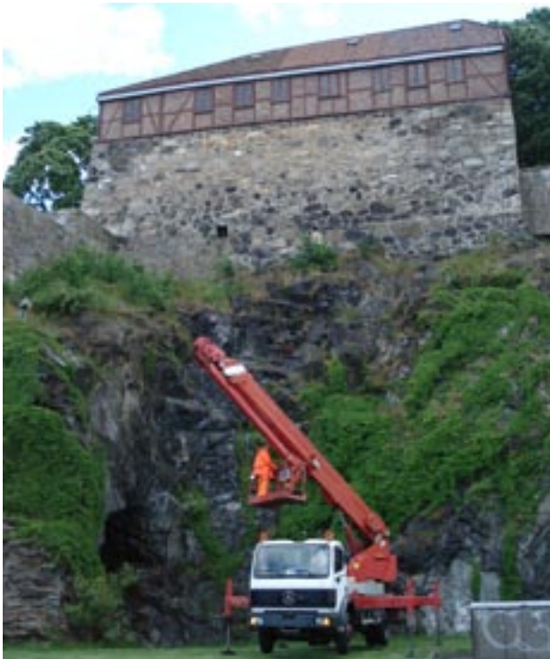
Ved vanskelig tilgjengelige områder er det en stor fordel å bruke lift.
