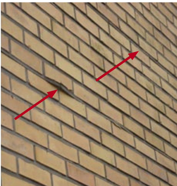
En uheldig sammenføring av prefabrikkert bjelke og det gamle murverket.
