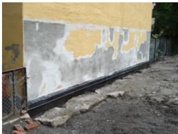
Toppen av fuktsikringen bør sikres med et kronebeslag. Her er det i tillegg plassert store steiner i bakken langs muren for å unngå vilkårlig utplassering av klatreplanter.
