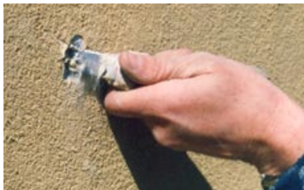
Renskjæring av sårsted etter stillasfeste.
