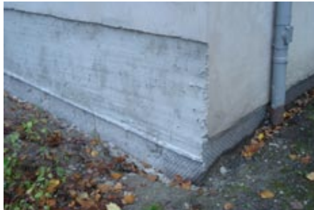
Eksempel på arbeid med offerpuss.
