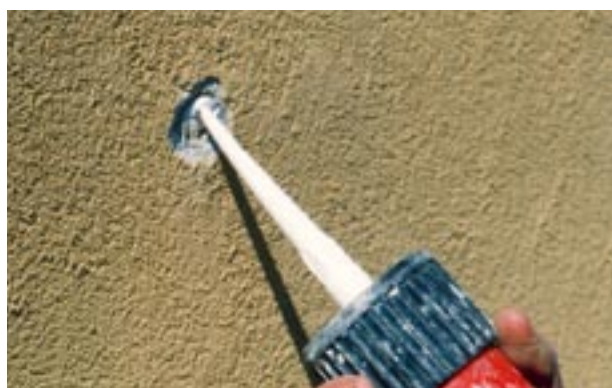
Fylling av hulrom kan utføres med fugemasse, alternativt med propper.
