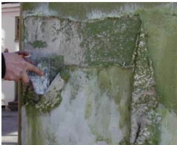
Tykkere malingslag kan fjernes med sparkelspade. Kilde: Murkatalogen P6: 2003.
