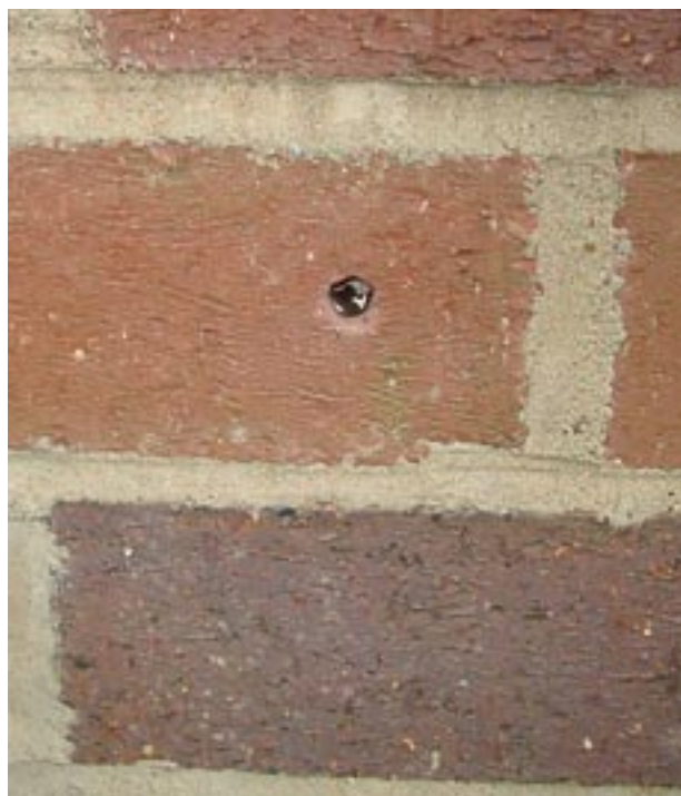
Ferdig og avkuttet
