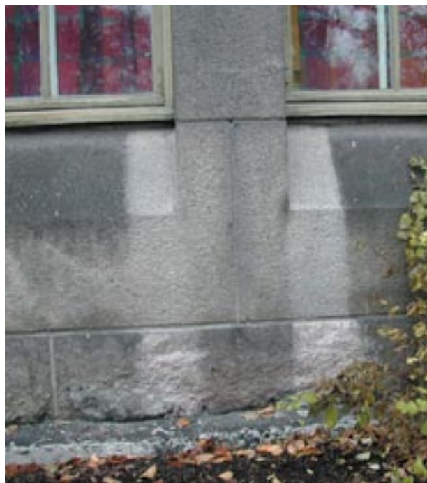
Prøvefelt, rengjøring av granitt. Kilde: Murkatalogen P6: 2003.
