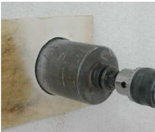
Et stykke puss friskjæres ved kjerneboring inn til underlaget (tegl/betong).
