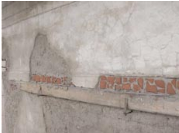
Innmuring av teglsteinsbiter. Kilde: Murkatalogen P6: 2003.
