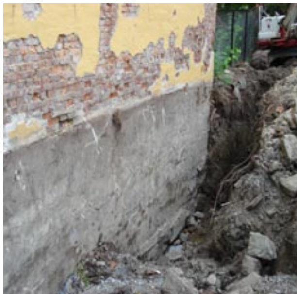
Oppgraving for fuktsikring av kjellermur
