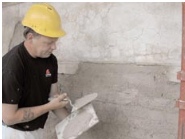
Grunning ved påkast
