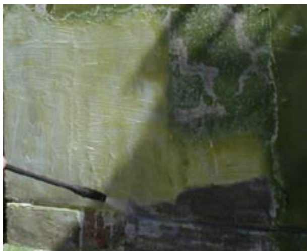
Demonstrasjon i bruk av malingsfjerner. Kilde: Murkatalogen P6: 2003.
