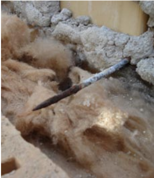
Gjenstående bindere ligner "strikkepinner" der de står som spyd ut fra bakvegg.
