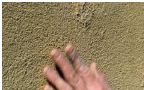
Overflaten bearbeides slik at strukturen blir mest mulig lik omkringliggende pussflate.
