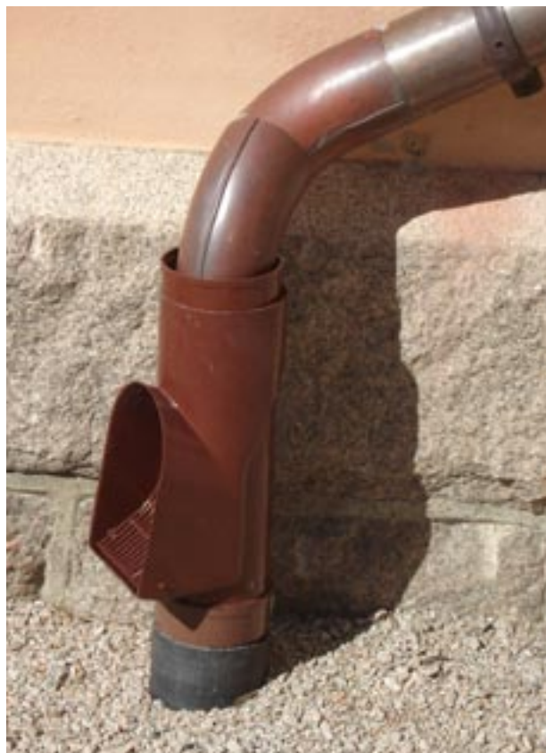
Ved overgang mot sokkel og terreng er det viktig å detaljere retningsendringer på nedløp og ev. utstyre overgangen mot terreng med en løvrisk.
