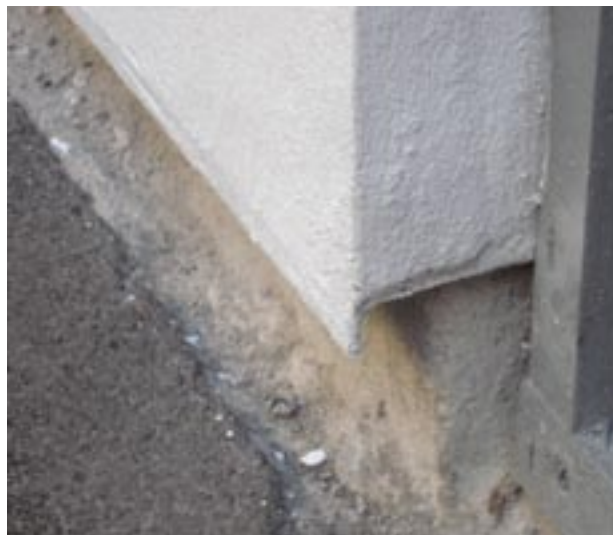
Her er grunnmuren utbedret med innslisset beslag.
