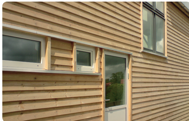
Vegg med skråskåret trekledning (weatherboards) før overflatebehandling. Foto: SINTEF Byggforsk
