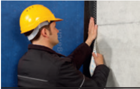
Vindsperre mot betong-/ murvegg
