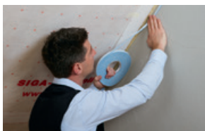
Dampbrems mot betong-/murvegg
