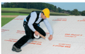
Montering av dampbrems ved isolasjon over sperrer
