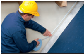
Underlagsduk mot betong-/murvegg
