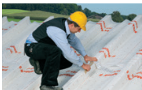
Montering av dampbrems ved takrehabilitering utenfra
