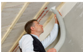
Montering av dampbrems ved blåseisolasjon
