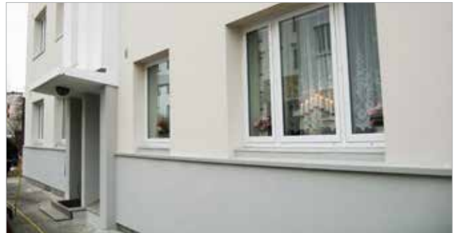
Etterisolerte fasader med Sundolitt EPS, Boligblokk i Ålesund
