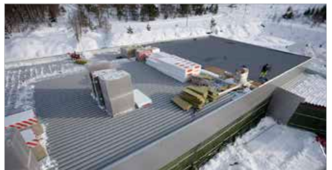
Isolering av tak med Sundolitt EPS, næringsbygg på Vatne
