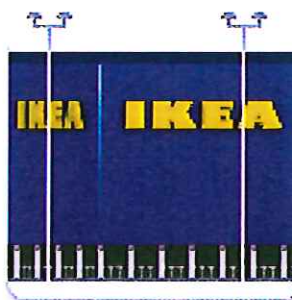
P-HUS Kungälv Kurva Stockholm 2010 14600 m 2 Span-Form + Penetron® betong Nybyggnation
