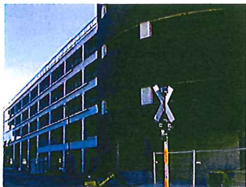
P-HUS Nya Malmö Central 2010 4000 m 3 Penetron® betong Nybyggnation
