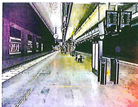
Nya Malmö Centralstation 2010-2011 Penetron® tätningar tak & taklanterniner Nybyggnation
