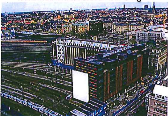
KUNGSBRON Stockholm City 2009 Bottenplatta & väggar i källargarage 1800 m 2 tätning av läckande betongsprickor
