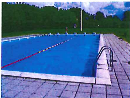
Friluftsbad Skurups Kommun Penetron® Rehabilitering 2005
