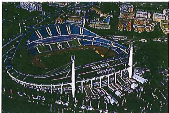
Nya ULLEVI Göteborg 2001 – 2011 Penetron® Rehab av armeringskorrosion & frostskadad konstruktionsbetong
