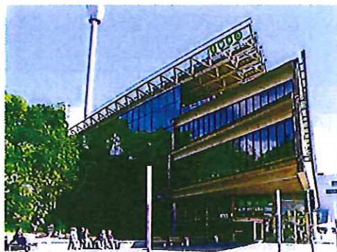
UNIVERSEUM Göteborg 2001 Penetron® behandling av nya akvarium/betongbassänger cirka 9000 m 2
