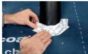
Gjennomføring i underlagsduker
