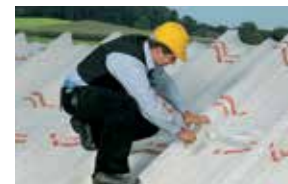
Montering av dampbrems ved takrehabilitering utenfra Side 76
