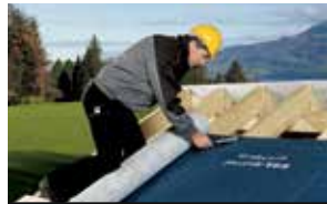
Montering av underlagsduk
