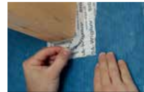
Gjennomføring i vindsperre
