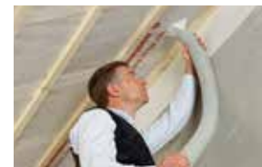
Montering av dampbrems ved blåseisolasjon Side 73
