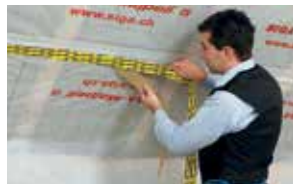
Overlapping av dampbrems Side 64
