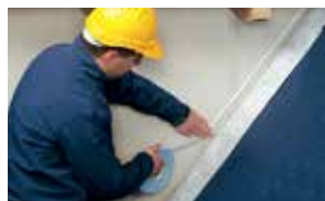
Underlagsduk mot betong-/murvegg
