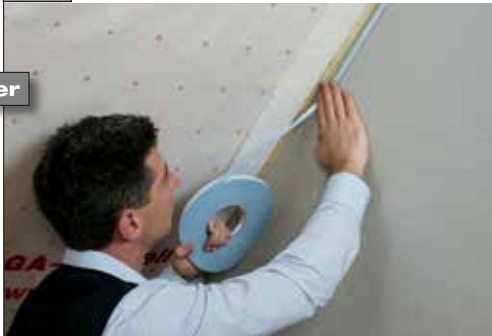
2 Sette på strengen etter montering av dampbremsen
