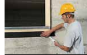
Vindu mot betong-/murvegg Side 36
