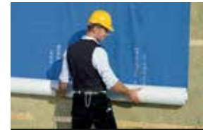
Montering av vindsperre
