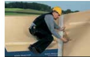
Liming av porøse trefiberplater
