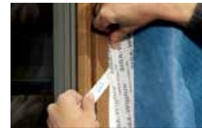
Vindu mot vindsperre
