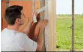
Vindu mot betong-/ murvegg
