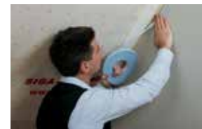
Dampbrems mot betong-/murvegg Side 30
