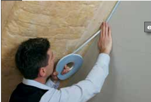
1 Sette på strengen før montering av dampbremsen
