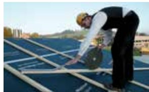
Montering av spikertett-tape
