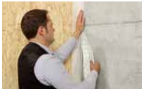
Trevegg mot betong-/ murvegg
