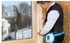
Vindu mot trevegg
