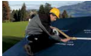
Overlapping av underlagsduker
