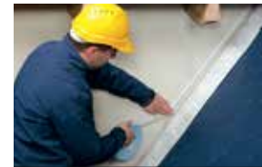
Underlagsduk mot betong-/murvegg Side 42
