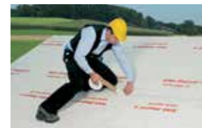
Montering av dampbrems ved isolasjon over sperrer Side 78
