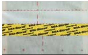
Overlapper av dampbrems
