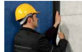
Vindsperre mot betong-/murvegg Side 40
