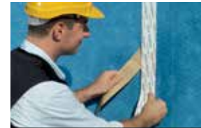
Overlapping av vindsperre
