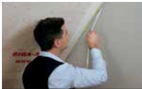
Dampbrems mot betong-/murvegg
