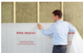
Montering av dampbrems på bindingsverk av tre
