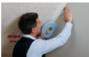
Dampbrems mot betong-/murvegg
