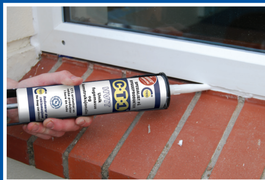
Tetter fuger umiddelbart
