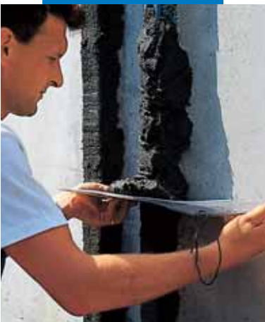
Forming av mørtelen
