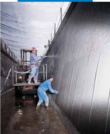
Bertini hydroelektrisk kanal - Robbiate (Como) - Italia: glatting med murskje
