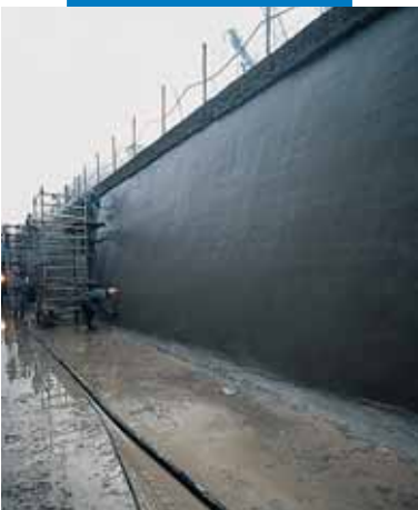
Bertini hydroelektrisk kanal - Robbiate (Como) - Italia: generelt overblikk
