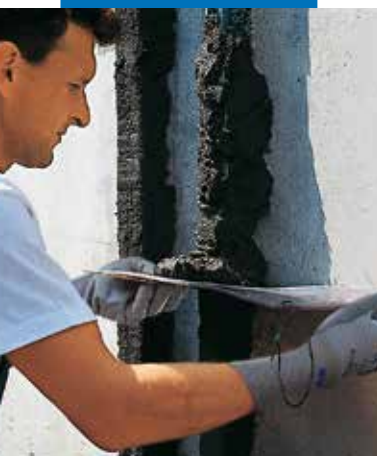
Forming av mørtelen
