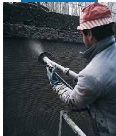
Bertini hydroelektrisk kanal - Robbiate (Como) - Italia: påføring med sprøyte
