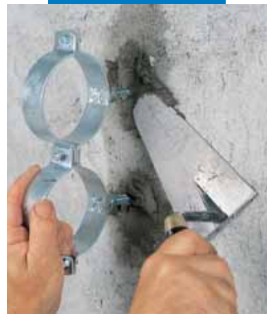
Festing av rørbraketter med Lampocem
