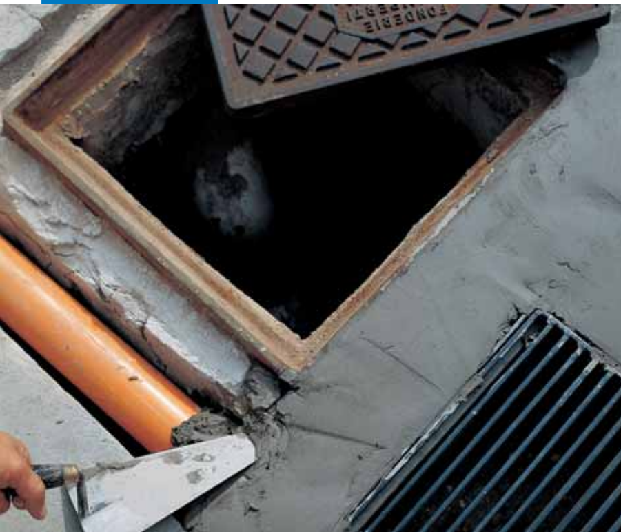
Innstøping av rør og kumlokk med Lampocem
