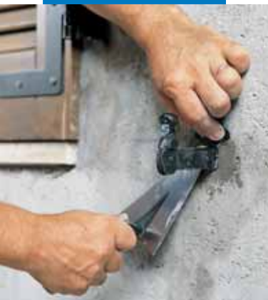
Festing av bolter til fundament for vinduer med Lampocem
