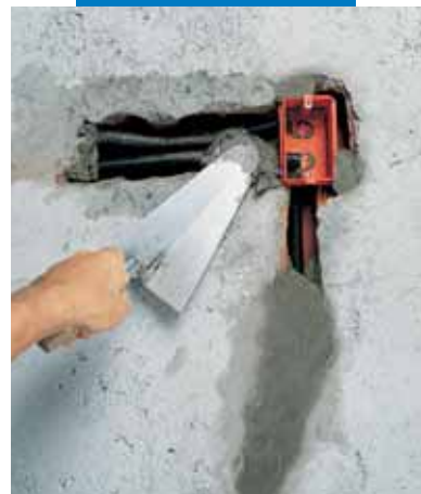
Festing av kabelrør og kapsler med Lampocem
