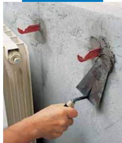
Festing av forankringsbolter til radiatorer med Lampocem
