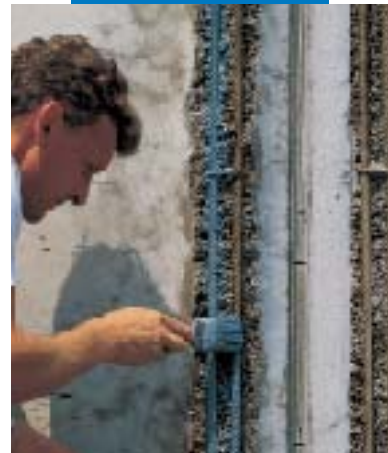
Påføring av Mapefer
