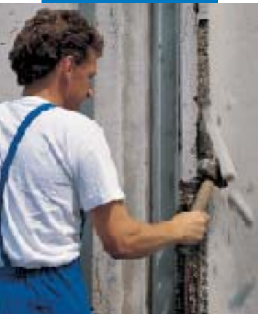
Fjerning av nedbrutt betong
