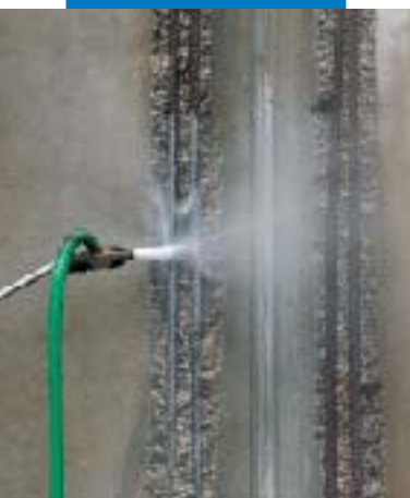
Rengjøring av armering
