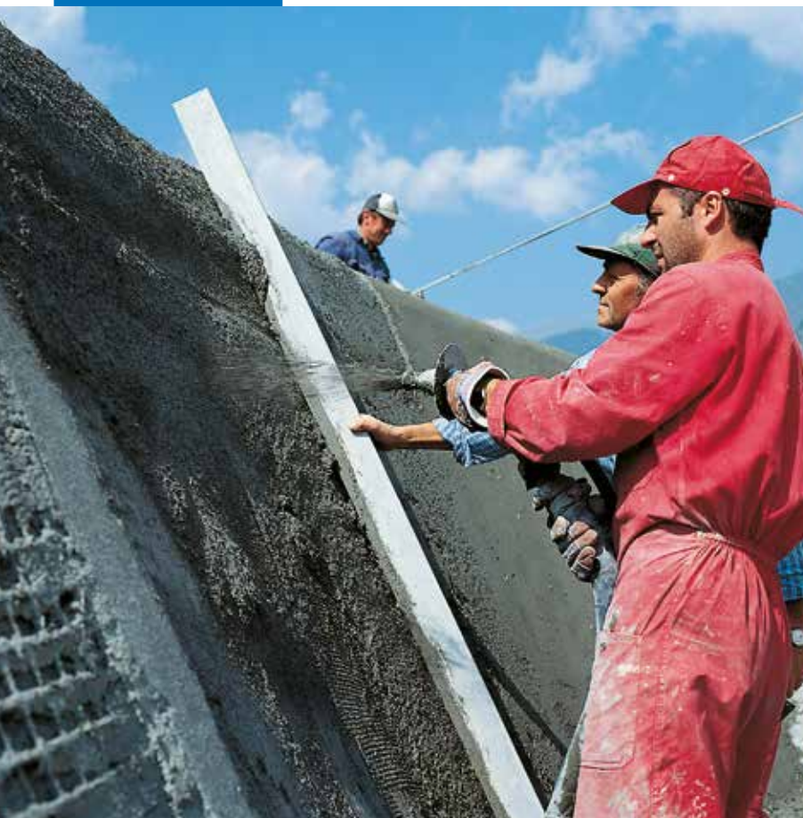
Påføring av Mapegrout T40 ved bruk av sprøyte
