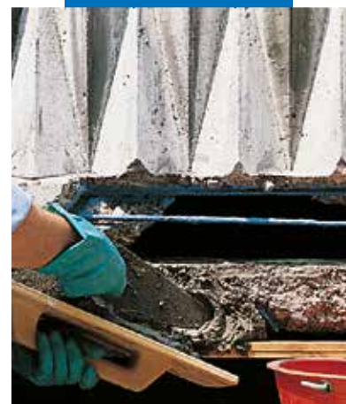
Reparasjon av balkong med Mapegrout T40
