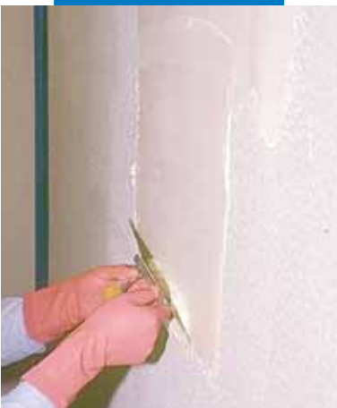
Påføring av limet med Mapegum WPS
