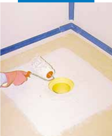
Påføring av Mapegum WPS rundt sluk i dusj
