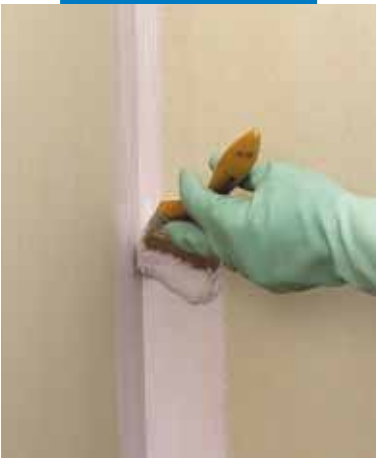
Påføring av Mapegum WPS med kost
