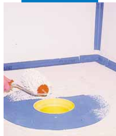
Spesialstykket med Mapeband er dekket med Mapegum WPS
