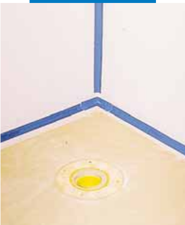
Vanntetting av vegger i badrom ved bruk av Mapegum WPS og Mapeband
