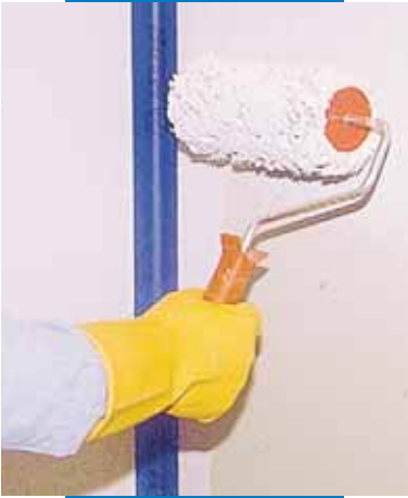
Påføring av Mapegum WPS med rulle på vegg
