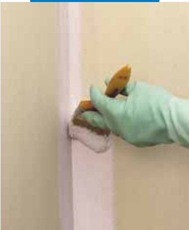
Påføring av Mapegum WPS med kost
