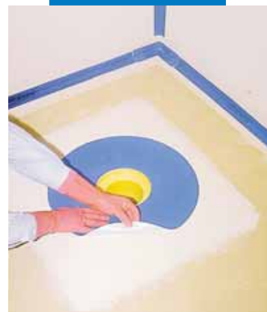
Påføring av spesialstykket med Mapeband over Mapegum WPS
