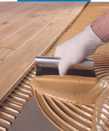
Påføring av Ultrabond P990 1K
