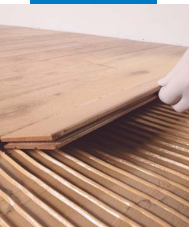
Installering av parkett
