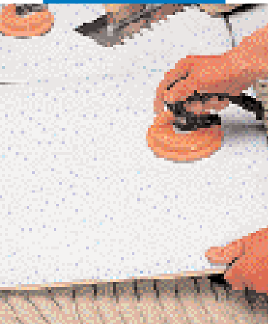
Legging av store fliser
