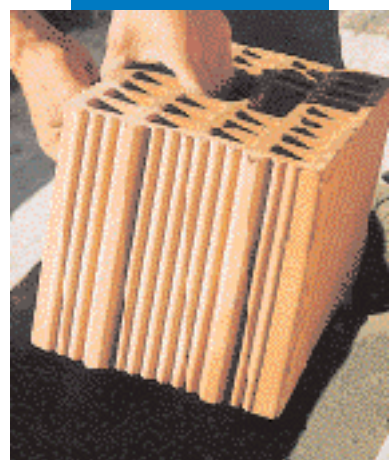
Teglblokk dyppes i Adesilex P4
