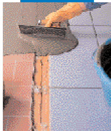
Avretting på eksisterende gulv med Adesilex P4
