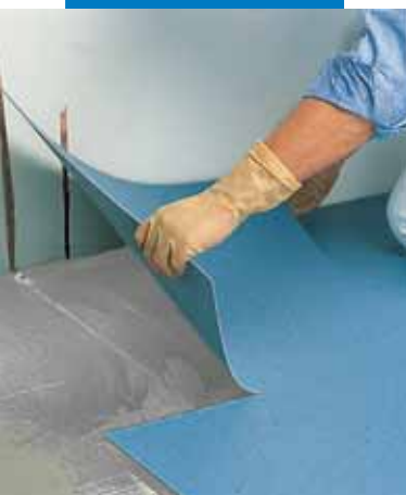
Legging av PVC fliser med Ultrabond Eco V4 Conductive
