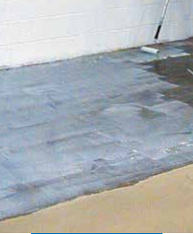
Påføring av Mapeprim SP
