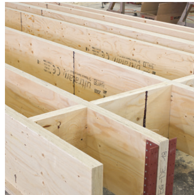
Eksempel på bjelkelagskonstruksjoner med Hunton Finerbjelken.
