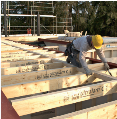
Eksempel på bjelkelagskonstruksjoner med Hunton Finerbjelken.
