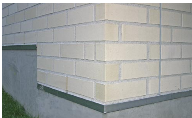
Figur 14: Rett beve- gelsesfuge hhv. 1/2 og halvannen stein inn fra hjørnet. Presis, rett fuge er ofte mest vellykket.
