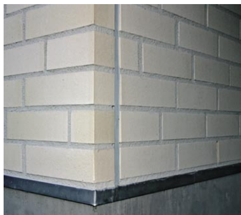
Figur 14: Rett beve- gelsesfuge hhv. 1/2 og halvannen stein inn fra hjørnet. Presis, rett fuge er ofte mest vellykket.
