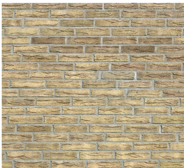
Figur 10: 1/4- og 1/2-steins løperforband med varierte sprang «sladret» ikke...
