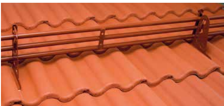
Bild 21. Snörasskydd grind komplett monterad på tak.
