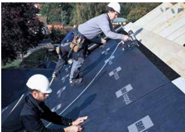
Icopal Ultra D - diffusjonstett asfalt underlagsbelegg.
