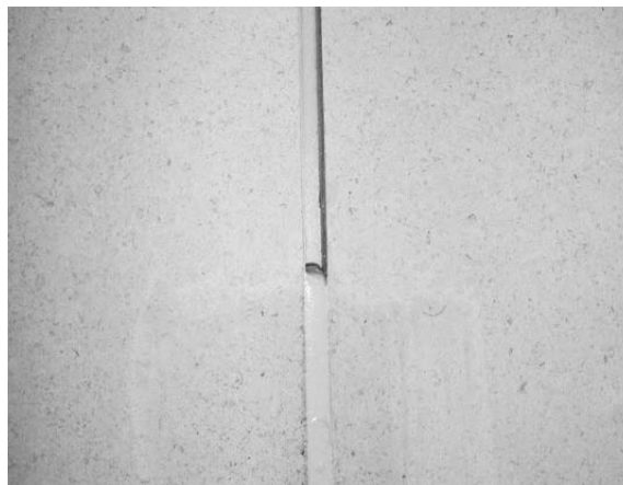
2. Fugebredde på 5-7mm (0.5 x platetykkelsen)
