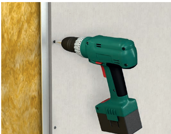
1. Skrues på stålstendere eller skrues/krampes på trestendere.
