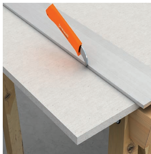
2. Rissing med Fermacell rissekniv
