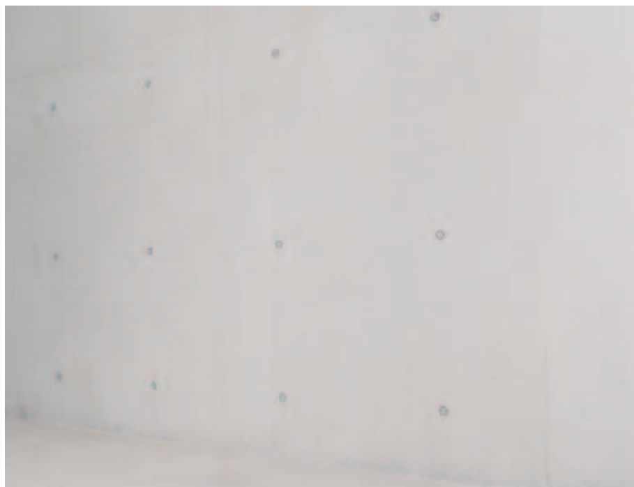
Innlimte betongkonuser med skyggefuge.
