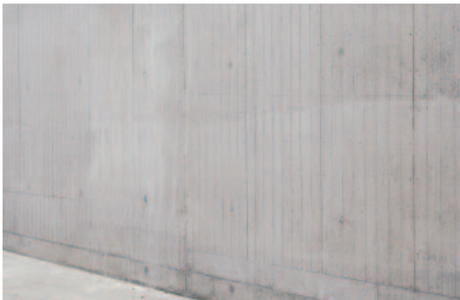
En ferdig vegg med innlimte betongkonuser.
