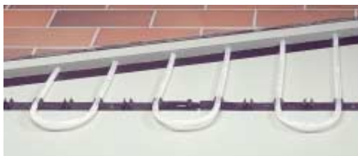
Wirsbo Gulvvarme i rørholderskinne innstøpt i avrettingsmasse
