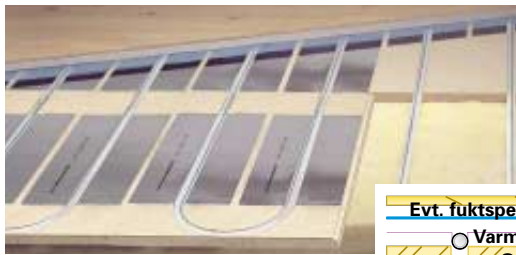
Wirsbo gulvvarmesponplate på bjelkelag Gulvvarmerør Wirsbo-pePEX Q&E 17x2 mm Lamellparkett, sponplate eller laminatgulv min. 7 mm
