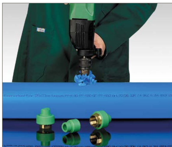
Gjennom boring av rørveggen
