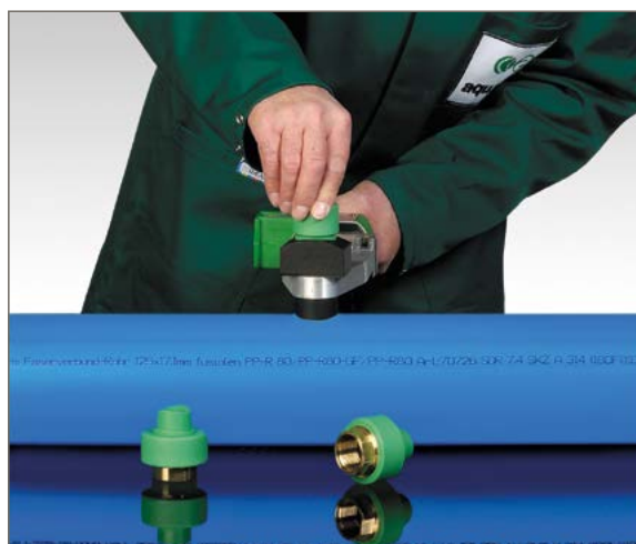
Oppvarming av rør og rørdel
