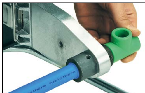
Oppvarming av rør og rørdel
